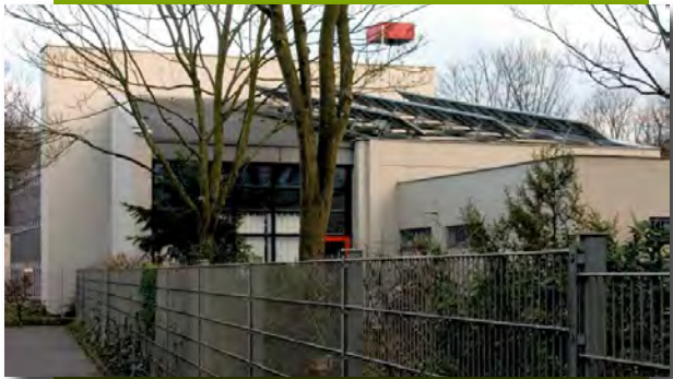
Auferstehungskirche mit Photovoltaikanlage
